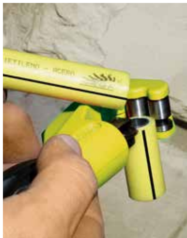
Corte con corta-tubo en obra.
