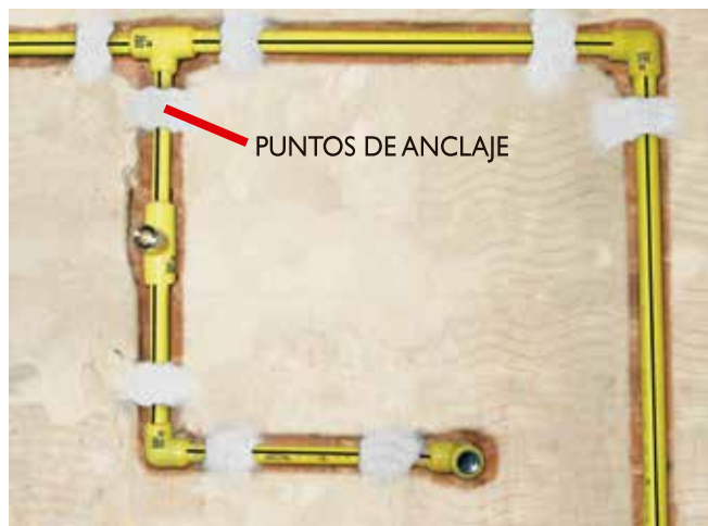
Vista parcial de instalación.
