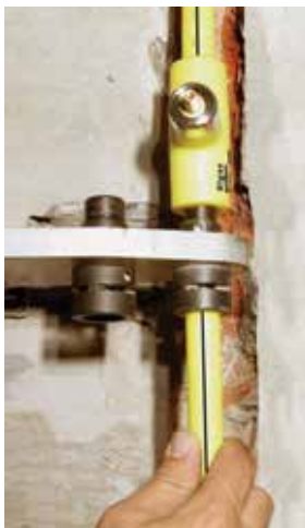
Thermofusión en la canaleta.
