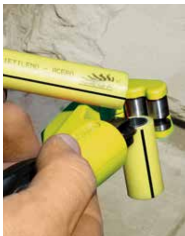
Corte con corta-tubo en obra.
