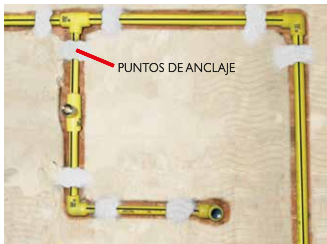
Vista parcial de instalación.
