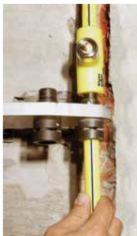
Thermofusión en la canaleta.
