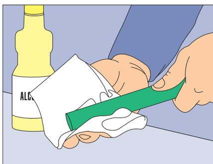
**3-** Limpiar la punta del caño y el interior del accesorio con un trapo embebido en alcohol común, inmediatamente antes de proceder a cada Thermofusión®.
